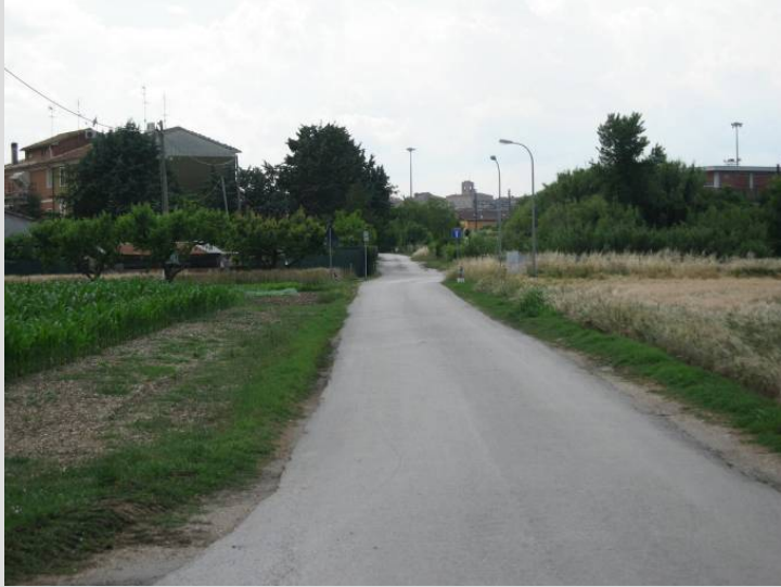
Viabilità da adeguare
